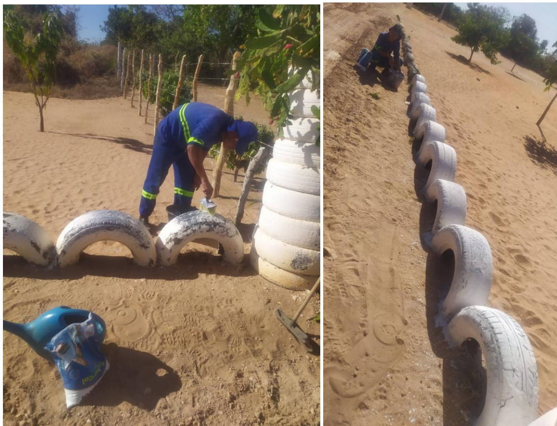
Figura 3 e 4 / Entrada com sinalização e reaproveitamento de pneu que iriam ser despejados no aterro controlado
