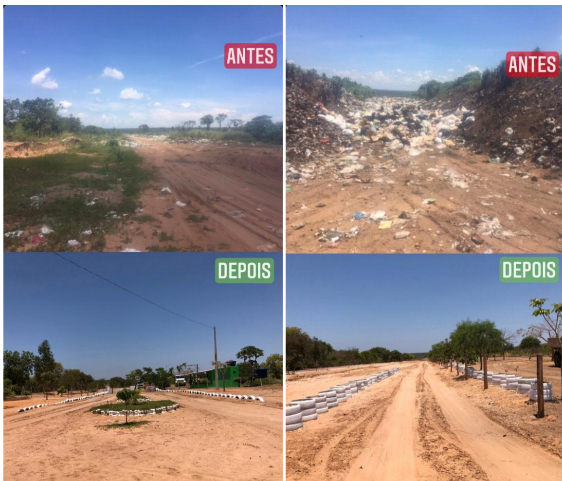
Figura 1 e 2 – ANTES o local de despejo dos resíduos sólidos da cidade é feito de qualquer forma, sem controle, sinalização de área e lixo espalhado por todo percurso. DEPOIS da implantação do Aterro Controlado, foi feita sinalização da estrada, delimitação do perímetro com cerca e guarita para permitir, controlar o acesso de pessoas e veículos, além de impedir animais e recolhimento de todo lixo espalhado pelo percurso.
