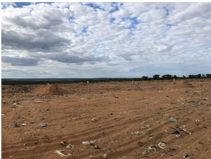
Figura 17/ por não ter sido uma área planejada, onde o solo deveria ser primeiro impermeabilizado e depois fosse colocando de forma compactada os resíduos, a área não possui canaletas de passagem de água que evitariam a infiltração para dentro dos resíduos compactados.
