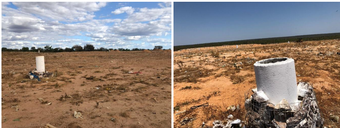
Figura 15 e 16 / sobre a pinha de resíduos compactados existe diversos tubos/manilhas para captar a produção do chorume assim aliviar os gases ao ar livre. Não há queima do chorume.
